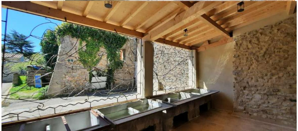
La toiture du lavoir a été totalement refaite avec des tuiles canal et des voliges apparentes en bois.
