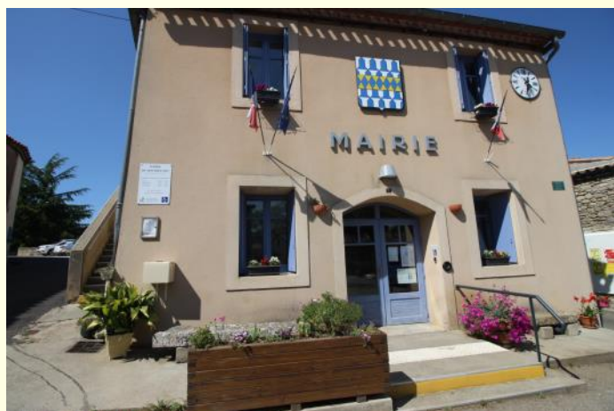
La main courante devant le rez de chaussée de la mairie
