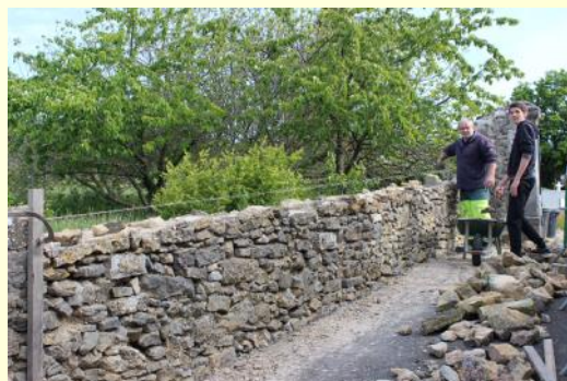
Les travaux de réfection du mur du cimetière
