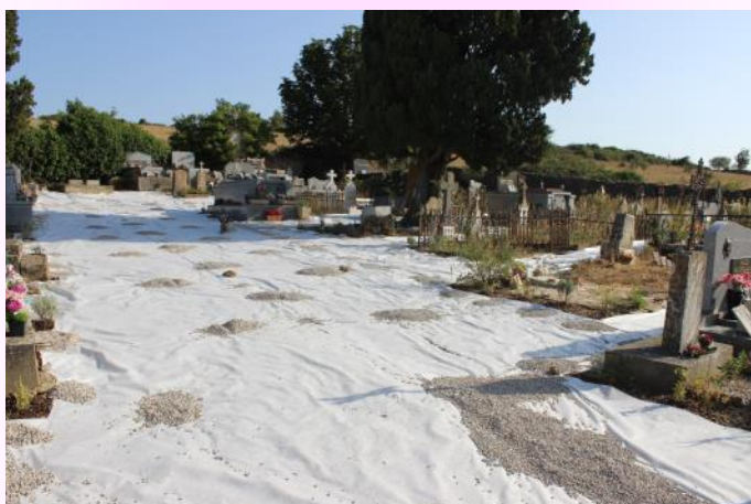
Le film géotextile dans les allées, avant la pose du gravier
