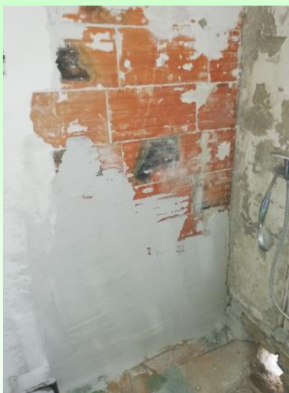
Douche de l'appartement communal : il a fallu tout refaire
