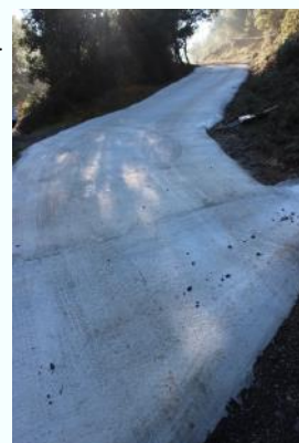
Partie bétonnée sur le chemin de la STEP
