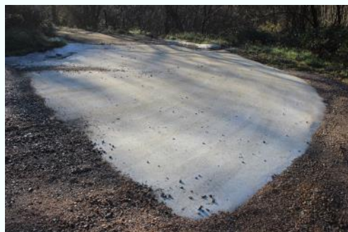
Le chemin de Bagaza : à gauche le passe-lisse au niveau du ruisseau et à droite le passe-lisse au niveau du grand virage
